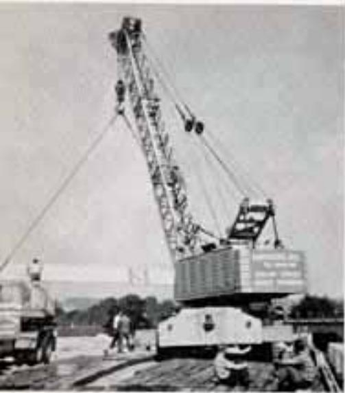
Plaatsen van voorgespannen betonbalken met 45 ton's mobiele kraan,
