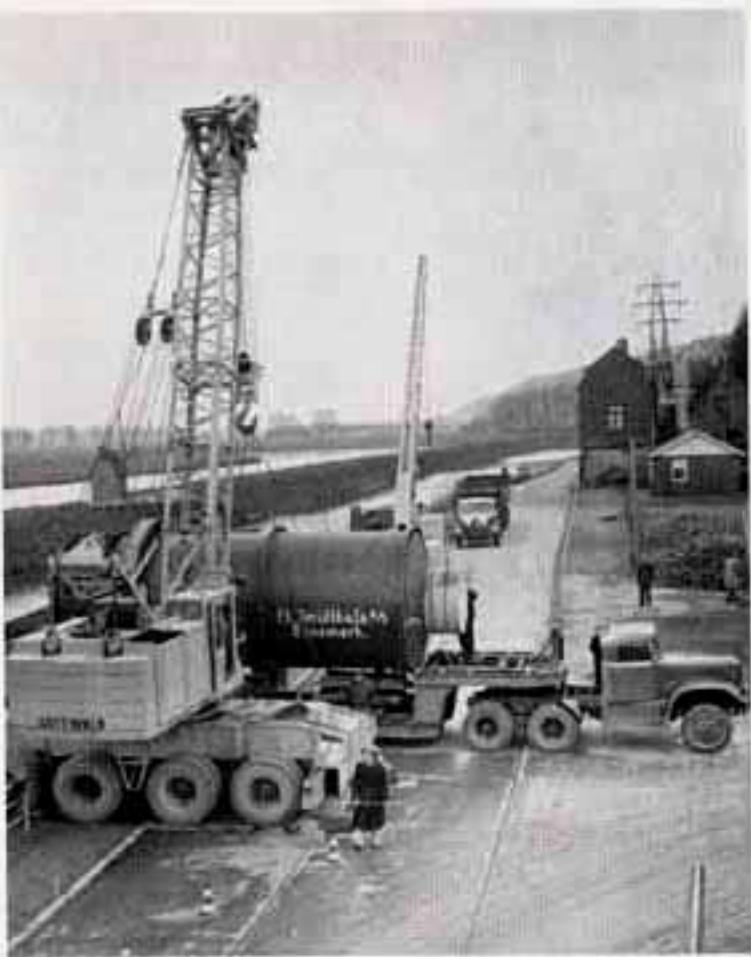
Overladen uit schip van 26 ton wegende cilinder op een van
