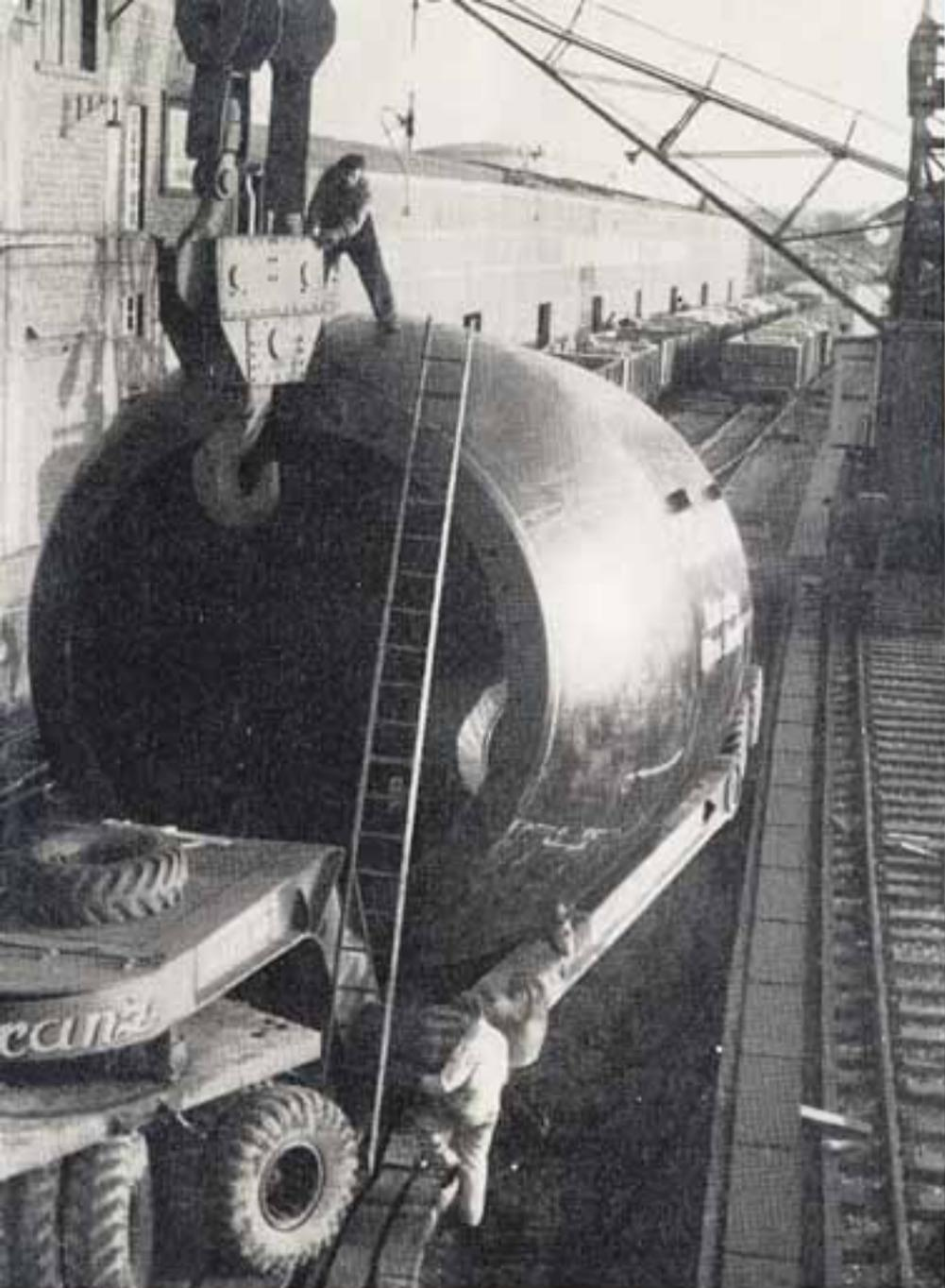
◀ Konverter, 65 t, 5700 mm  $\Phi$ , auf Tieflader mit seitenverstellbaren Trägerwangen, die es ermöglichen, die Bodenfreiheit unter dem geladenen Gut zu bestimmen. Hindernisse während der Fahrt (Unterführungen oder Fahrbahnwellungen) werden durch hydraulisches Heben oder Senken überwunden.
